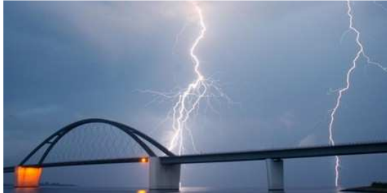
Noch steht sie: Die 1963 errichtete Brücke über den Fehmarnsund hat schon manchem schweren Wetter getrotzt. Bild: dpa
