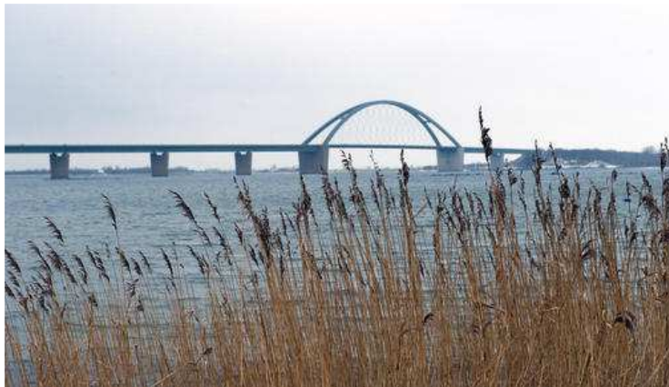
Das Land Schleswig-Holstein drängt auf Ersatz für die alte Brücke über den Fehmarnsund. © dpa
