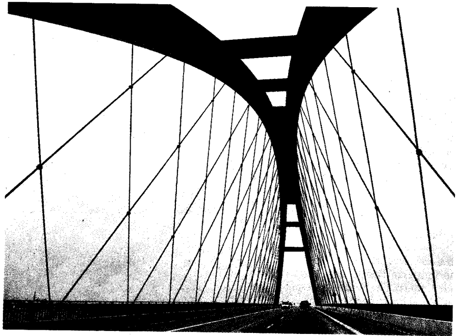
Windanfällig: Die Brücke über den Fehmarnsund soll ersetzt werden.
