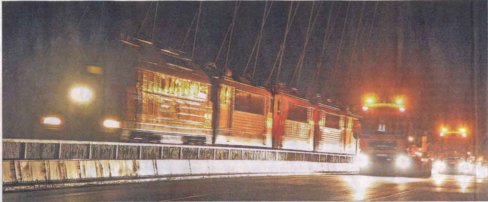
Regelmäßig wird die Tragfähigkeit der Sundbrücke getestet. Jüngstes Ergebnis: Für eine elektrische Oberleitung würde es reichen. Foto: Daniela Nyfeler
