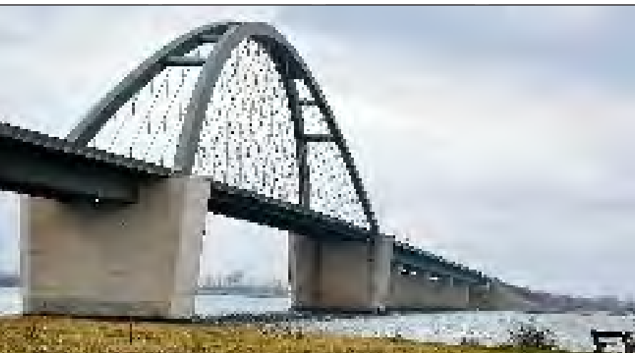
Laut der Deutschen Bahn hält die Fehmarsundbrücke dem Straßen- und Schienenverkehr nach Eröffnung der Festen Fehmarsbeltquerung nicht stand. • Foto: Garton
